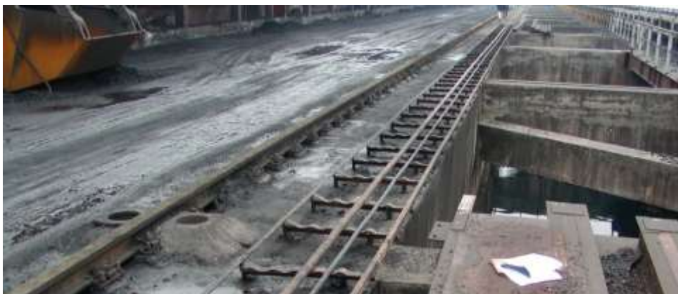
Prometna površina u zaleđu obalne konstrukcije
