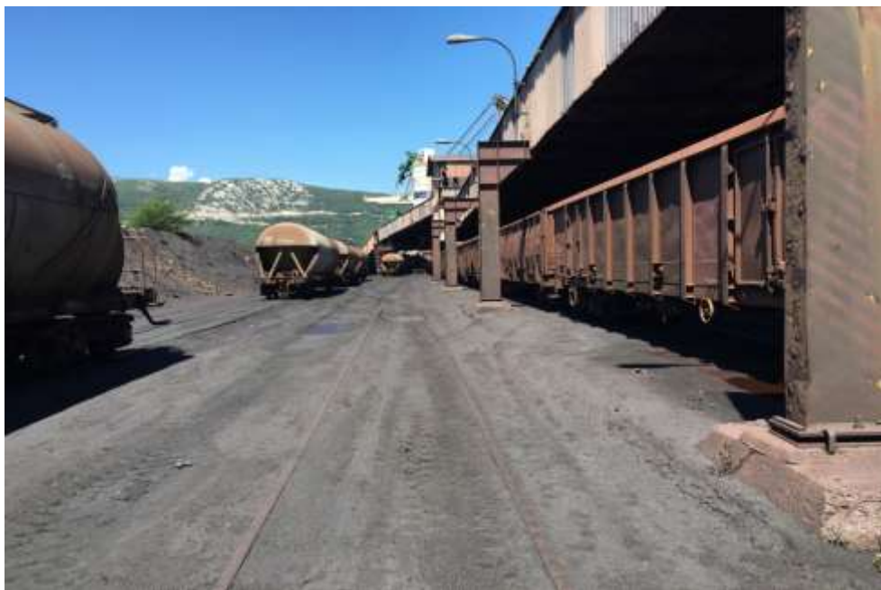
Postojeće stanje kolosijeka
